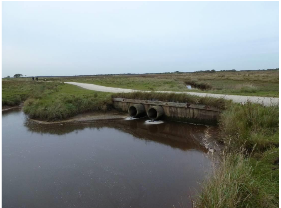
Enigszins belemmerde doorvoer van water in het geul en slenkensysteem op de Binnenkwelder.
