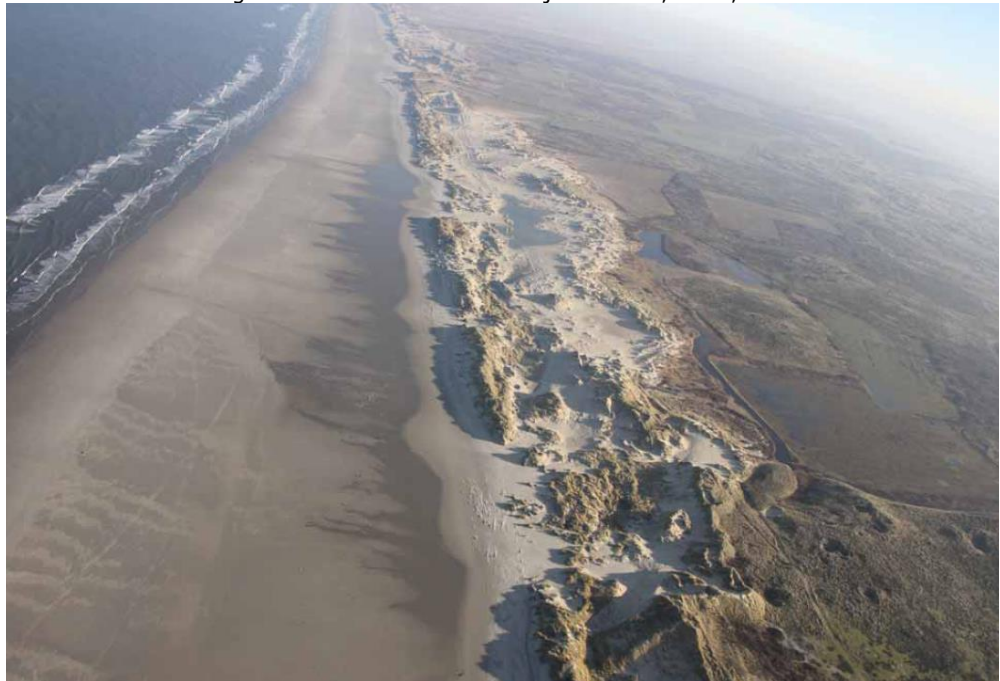
f Vogelvlucht van de duinen tussen paal 16 en 20 in oostelijke richting. (foto Rijkswaterstaat)
