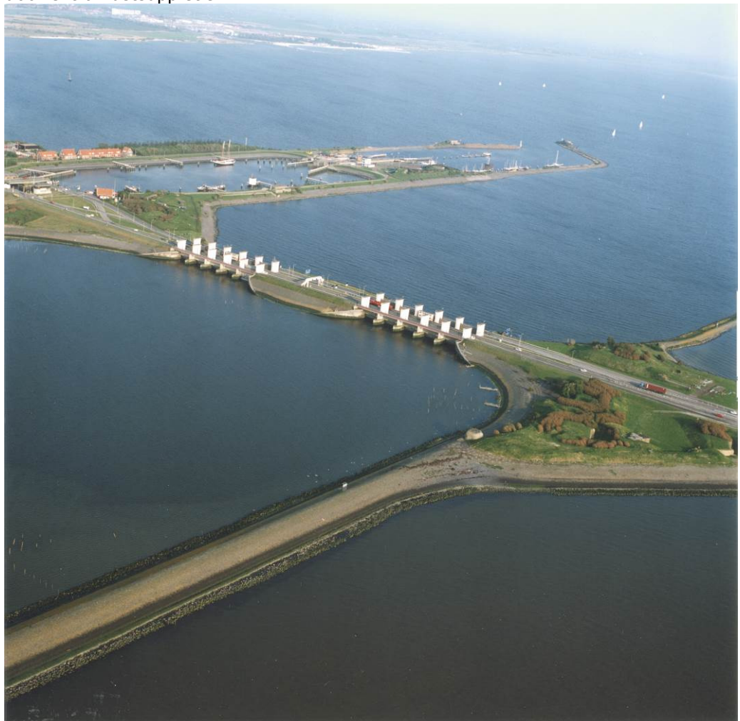
Foto 4.6. Afsluitdijk met Lorentzsluizen. (Foto Rijkswaterstaat)
